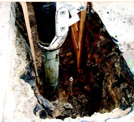
La flèche dynamique brevetée par RSP permet d'aspirer sans effort dans des terrains collants
